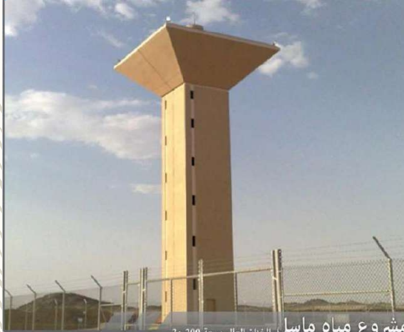
مشروع مياه ماسل الخزان العالي بسعة 200 م 3 الخط الناقل بطول 45 كم الخزان الأرضي بسعة 1,250 م 3
